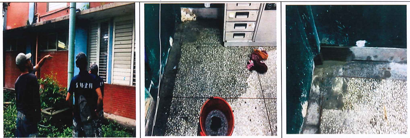
東大樓一甲、三丙教室牆角滲水已修繕完畢
