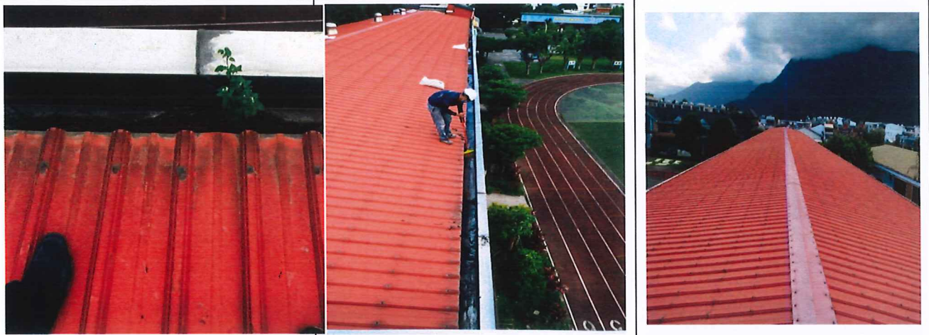
東大樓、北大樓、幼兒園等屋頂鐵皮水槽清淤、清理垃圾及植物
