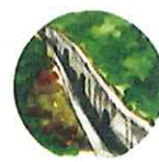
坡邊排水 保持暢通
